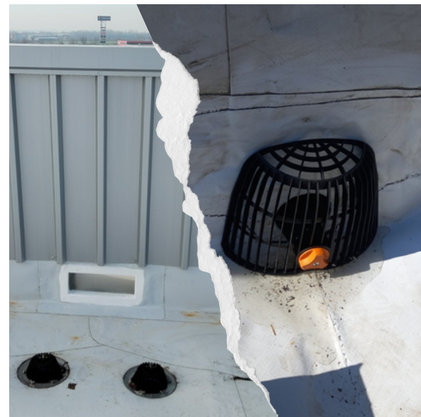
Ugradnja slivnika, slivničkih zaštita (rešetki) i otparivača
